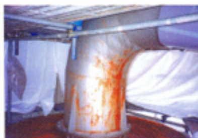
排気ダクト・溶射施工前
