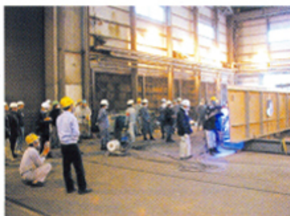
橋梁溶射状況2
