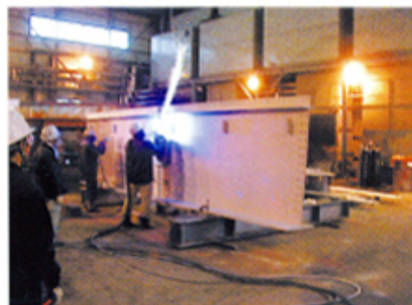
橋梁溶射状況1
