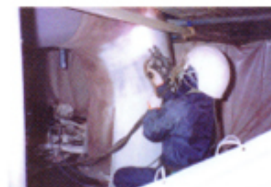
溶射作業中 (亜鉛/アルミ)
