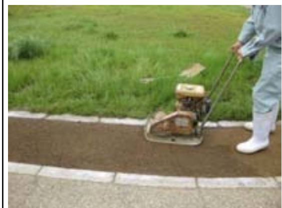
散布後転厚作業
