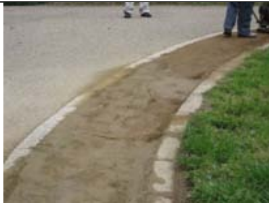
5月中旬施工 真砂土にて補修
