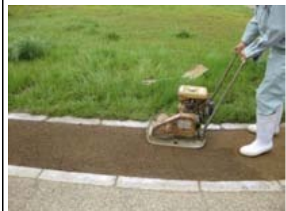
散布後転厚作業
